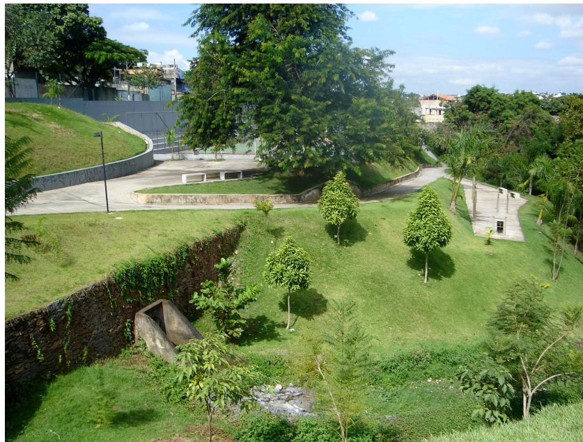
Figura 4.4 – Parque Ecológico 1º de Maio (obra concluída)
