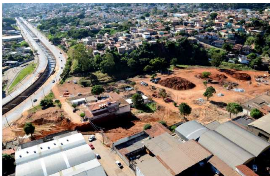
Figura 4.29 – Vista do trecho jusante da bacia, durante a execução das obras da Via 210
