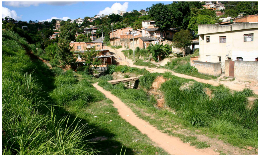
Figura 4.6 – Vista do Córrego Baleares antes das intervenções
