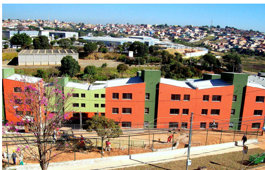
Figura 4.24 – Vista do Conjunto Habitacional R4 (obra concluída)
