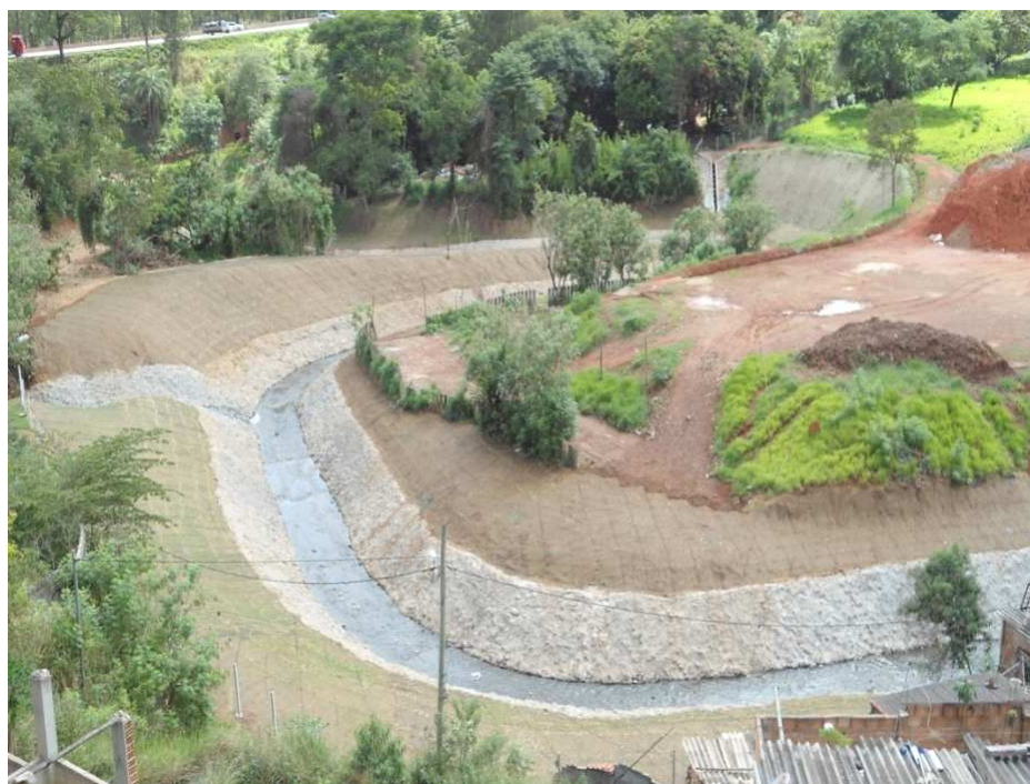
Figura 4.34 – Vista do Córrego Bonsucesso, próximo ao Anel Rodoviário, após as intervenções
