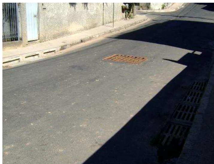
Figura 4.19 – Implantação de sistemas de drenagem pluvial (obra concluída)
