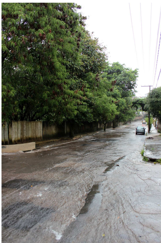
Figura 6.5 - Vista geral do sistema a partir de montante
