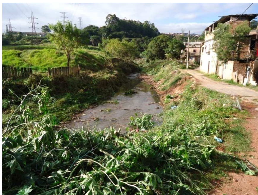
Figura 4.31 – Vista do Córrego Bonsucesso, próximo à Rua Terezinha França, antes das intervenções
