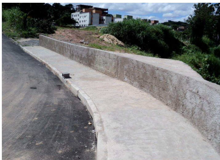
Figura 4.18 – Tratamento de erosões e contenção de taludes (obra concluída)
