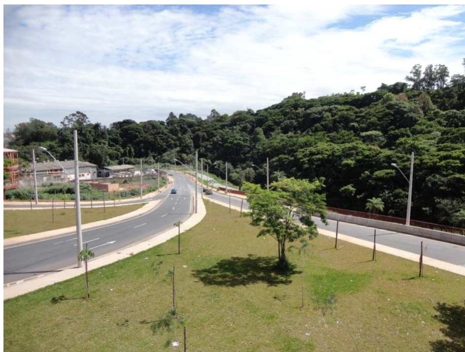
Figura 4.30 – Vista de trecho concluído da Via 210
