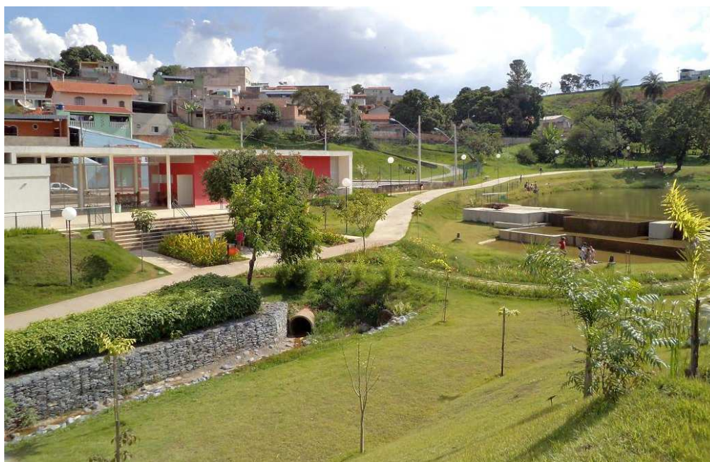
Figura 4.12 – Vista do Parque Nossa Senhora da Piedade (obra concluída)
