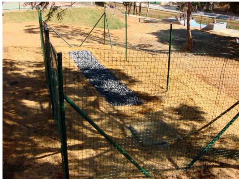
Figura 6.3 - Trincheira de infiltração
