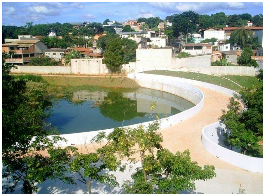
Figura 4.5 – Vista da Bacia de Contenção de Cheias implantada na área do Parque (obra concluída)
