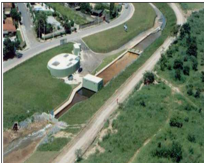
Figura 7.2 - Vista aérea da Estação de Tratamento das Águas Fluviais dos Córregos Ressaca e Sarandi
