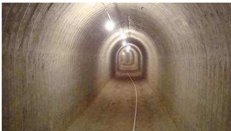
Figura 4.17 – Galeria de drenagem (túnel bala) sob o Anel Rodoviário (obra concluída)
