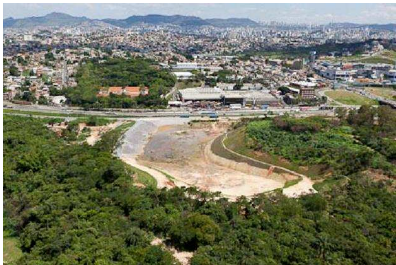
Figura 4.15 – Vista geral da bacia de detenção de cheias (obra concluída)
