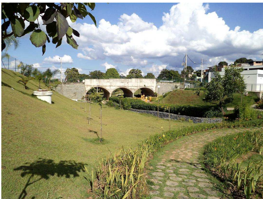
Figura 4.13 – Vista do pontilhão implantado no Parque Nossa Senhora da Piedade (obra concluída)
