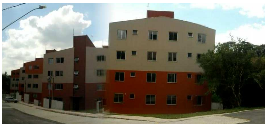
Figura 4.23 – Vista do Conjunto Habitacional R2 (obra concluída)
