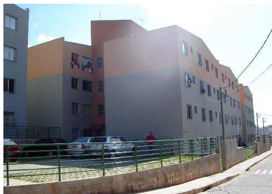
Figura 4.25 – Vista do Conjunto Habitacional R5 (obra concluída)
