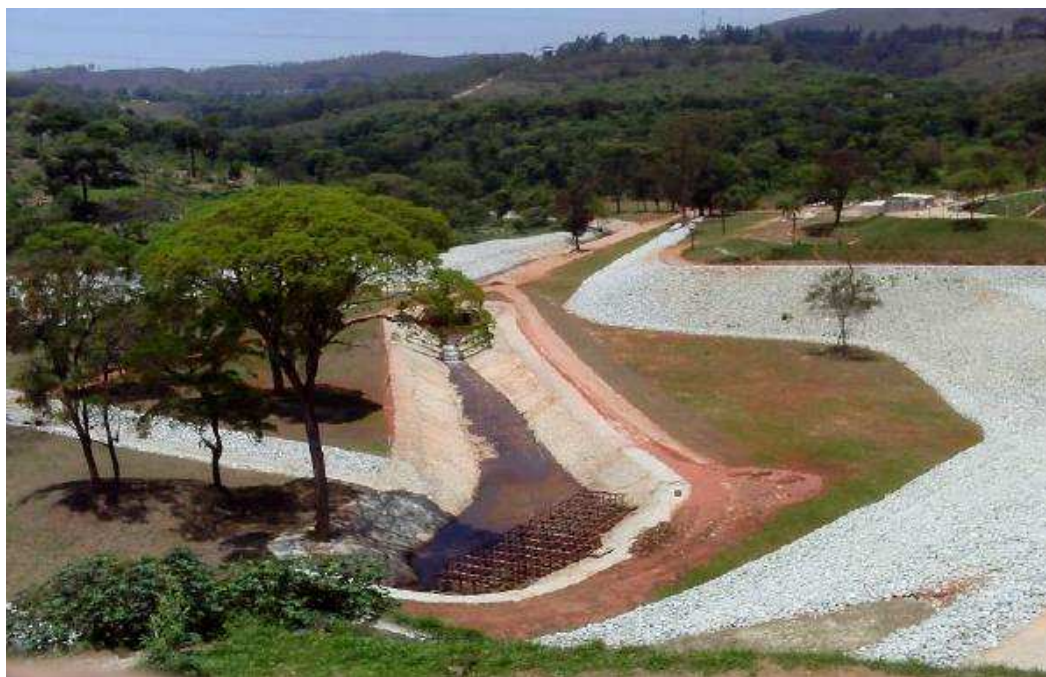
Figura 4.26 – Vista da bacia de retenção de cheias (obra concluída)
