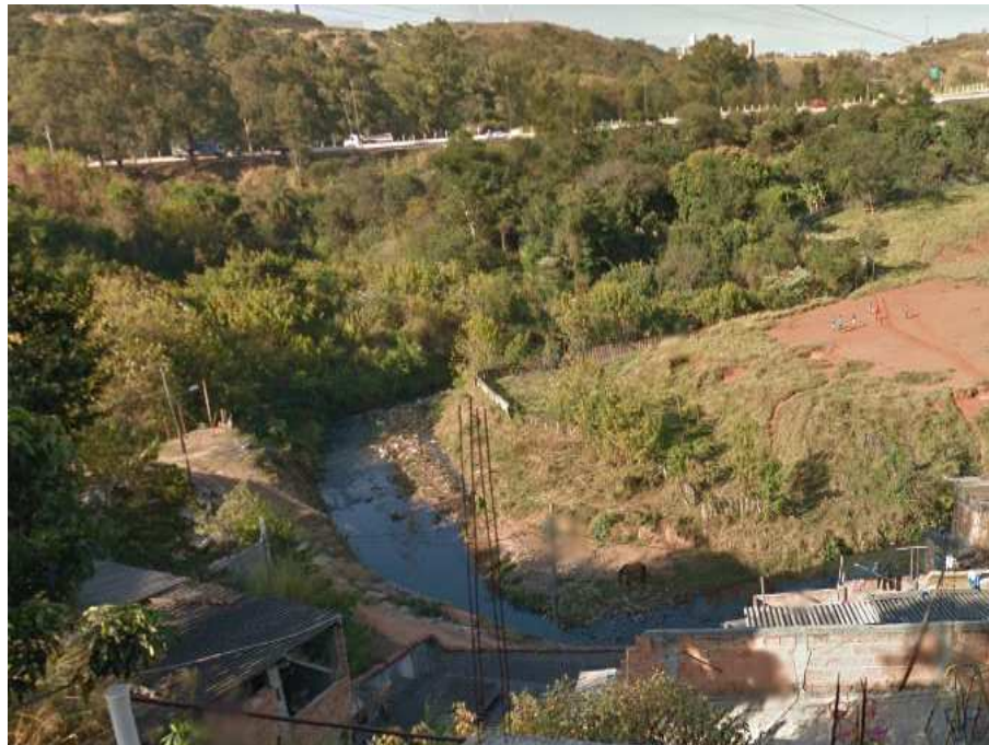
Figura 4.32 – Vista do Córrego Bonsucesso, próximo ao Anel Rodoviário, antes das intervenções
