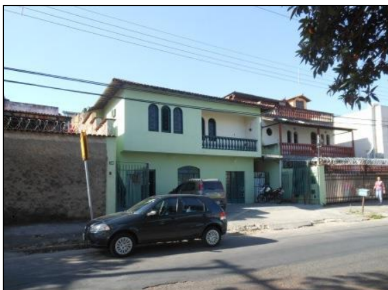
Figura 13 – Edificação utilizada como depósito de mercadorias, localizada ao lado do empreendimento (VM). Fonte: Ecominas, 2015.
