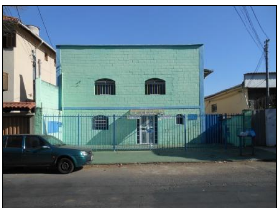
Figura 21 – Imóvel localizado na Rua Cornélio Cerqueira. Fonte: Ecominas, 2015.
