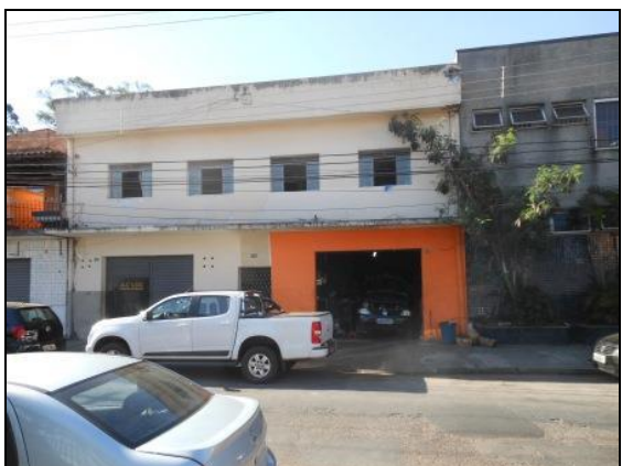
Figura 15 – Oficina mecânica situada às margens da Rua Cornélio Cerqueira. Fonte: Ecominas, 2015.
