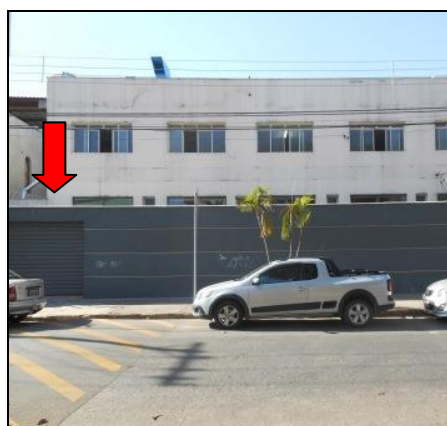
Figura 08 – Vista do Acesso 03. Fonte: Ecominas, 2015
