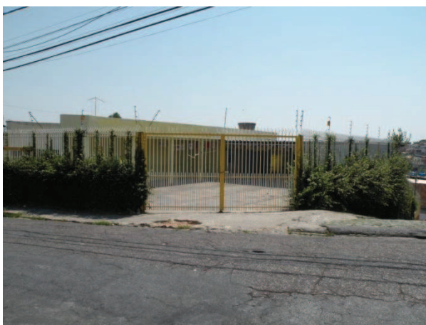
FOTO 77 – Vista da edificação da Rua Itapetinga, nº 702, esquina com Rua Borborema de uso serviços de veículos, com 1 pavimento.
