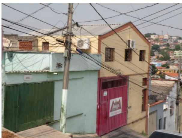
FOTO 03: Vista da edificação com parte da fachada lateral esquerda.
