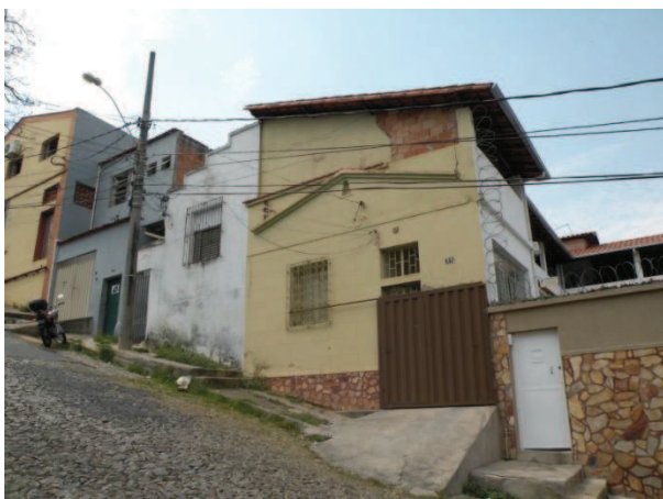
FOTO 23 – Vista do 2º lote à direita, situado à Rua Adriano Modesto, nº 85, de uso residencial, com dois pavimentos.
