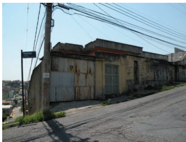
FOTO 78 - Vista da edificação da Rua Itapetinga, nº 662, de uso misto residencial e de serviços de chaveiro, com 1 pavimento.
