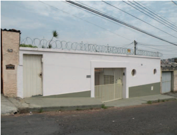
FOTO 53 – Vista da edificação da Rua Primeiro de Maio, nº 226, de uso residencial, com 1 pavimento.
