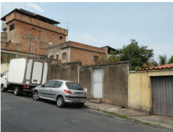
FOTO 69 - Vista da edificação da Rua Itapetinga, nº 651, com tipologia e uso residencial, com 1 pavimento.
