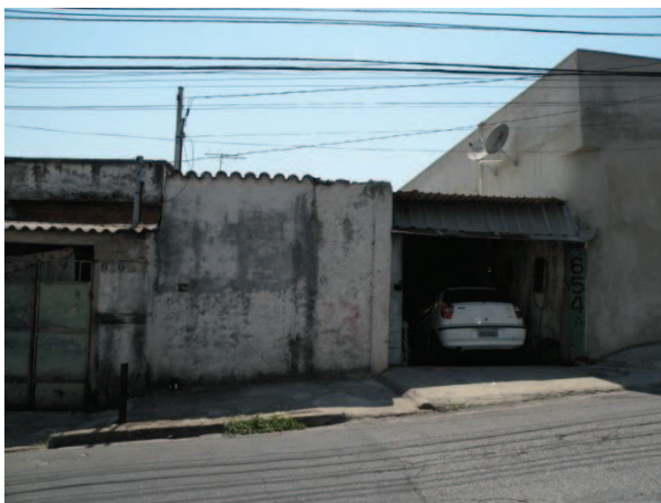
FOTO 79 - Vista da edificação da Rua Itapetinga, nº 654, uso de serviços de mecânica, com um pavimento.
