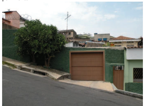
FOTO 58 - Vista da edificação da Rua Pedro Moura, nº 69, de uso residencial, com um pavimento.
