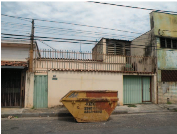
FOTO 49 - Vista da edificação da Rua Primeiro de Maio, nº 272, de uso residencial, com um pavimento.
