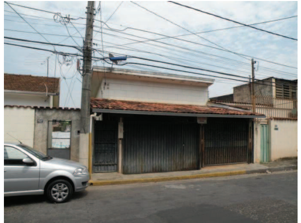
FOTO 48 - Vista da edificação da Rua Primeiro de Maio, nº 276, com uso residencial, com um pavimento.
