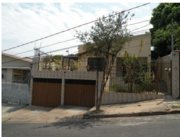
FOTO 85 - Vista da edificação da Rua Jacinto Vieira, nº 78, de uso residencial, com dois pavimentos.
