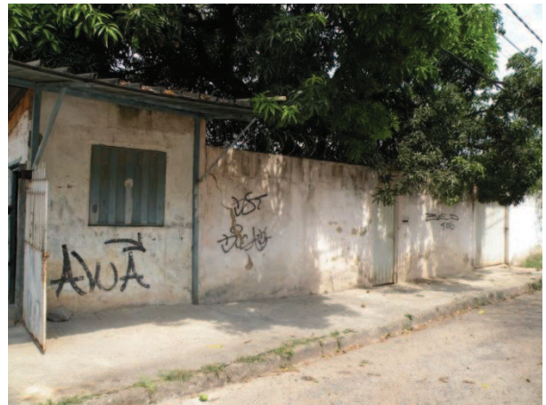
FOTO 44 - Vista da edificação da Rua Primeiro de Maio, nº 320, de tipologia e uso residencial, com um pavimento.
