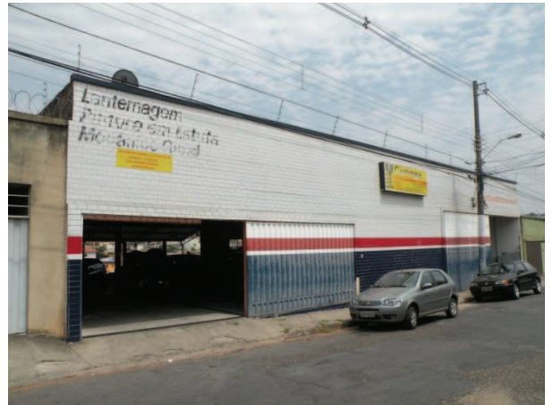
FOTO 56 - Vista da edificação da Rua Primeiro de Maio, s/nº, com tipologia de galpão e uso não-residencial de lanternagem de veículos, com 1 pavimento.
