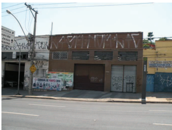
FOTO 91 - Vista da edificação da Av. Antônio Carlos, nº 2066, com tipologia de galpão e uso de indústria de abate de aves, com dois pavimentos.
