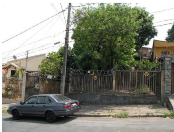
FOTO 84 - Vista da edificação da Rua Jacinto Vieira, nº 70, de uso residencial, com um pavimento.
