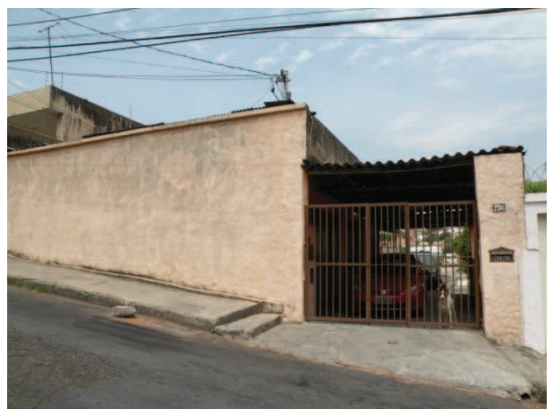
FOTO 52 - Vista da edificação da Rua Primeiro de Maio, nº 236, de uso residencial, com um pavimento.
