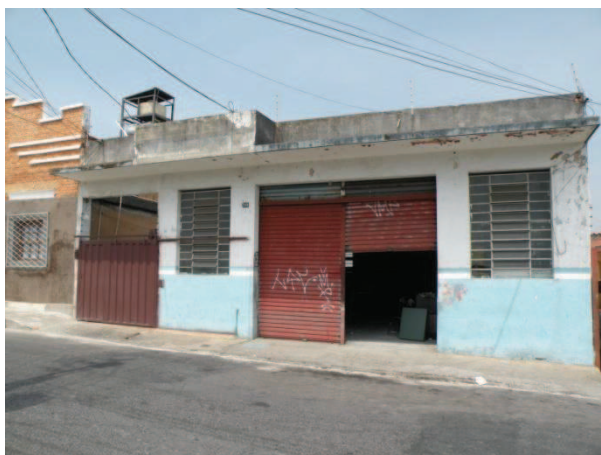
FOTO 73 - Vista da edificação da Rua Itapetinga, nº 599, de uso não-residencial de indústria de serralheria, com um pavimento.
