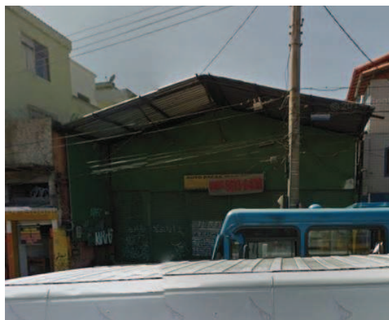
FOTO 100- Vista da edificação da Av. Antônio Carlos, nº 2204, com tipologia de galpão e sem uso, com 2 pavimentos.
