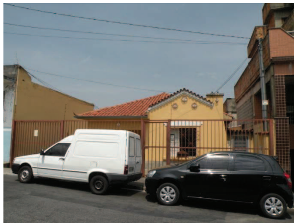
FOTO 72 - Vista da edificação da Rua Itapetinga, nº 617, de tipologia e uso residencial, com um pavimento.
