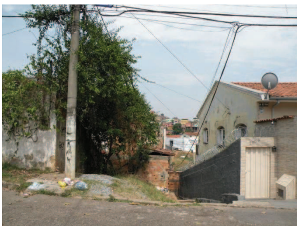
FOTO 45 - Vista da edificação da Rua Primeiro de Maio, nº 294, de uso residencial, com 2 pavimentos.
