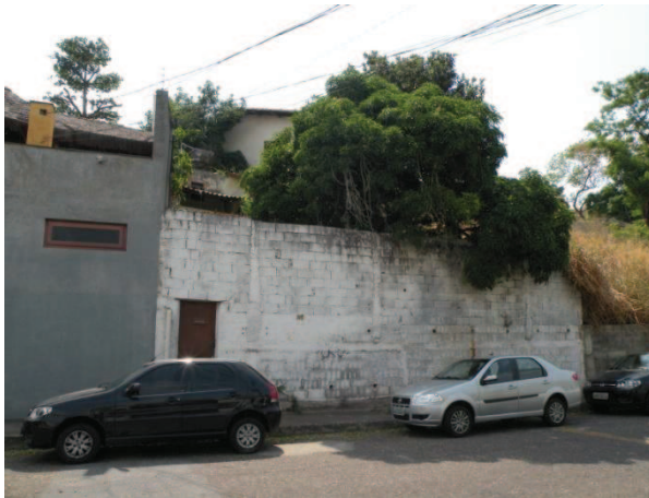
FOTO 41 – Vista da edificação da Rua Primeiro de Maio, nº 355, de uso residencial, com 1 pavimento.
