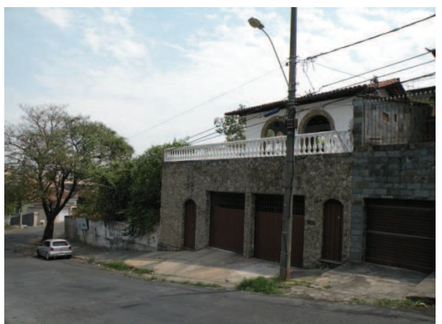
FOTO 22 – Vista de outro vizinho de fundos, construção da Rua Jacinto Vieira, nº 106, com tipologia e uso residencial, com 2 pavimentos.
