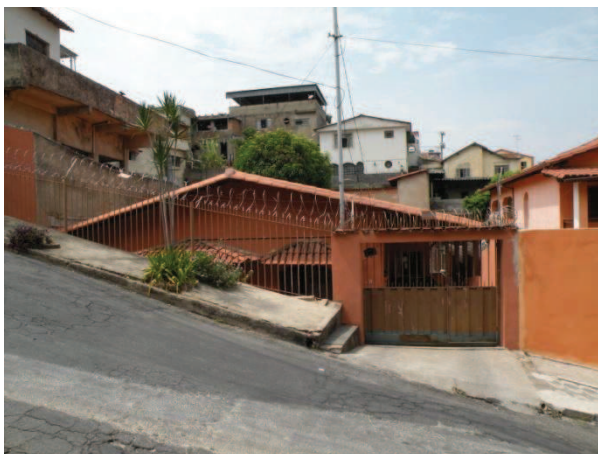
FOTO 61 - Vista da edificação da Rua Pedro Moura, nº 39, de uso residencial, com um pavimento.
