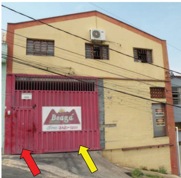
FOTO 01: Fachada frontal da edificação. Vista do acesso de pedestre (seta vermelha) e do acesso de veículos ao empreendimento (seta amarela).
