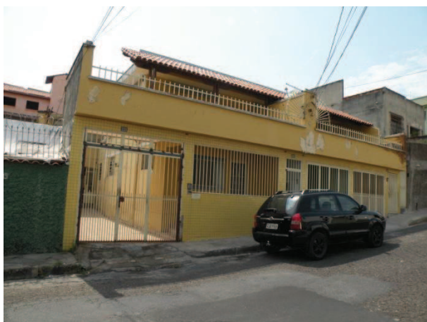
FOTO 35 – Vista da edificação da Rua Primeiro de Maio, nº 221, de uso residencial, com dois pavimentos.
