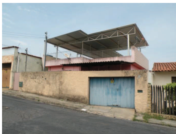
FOTO 64 - Vista da edificação da Rua Itapetinga, nº 725, de uso residencial, com dois pavimentos.
