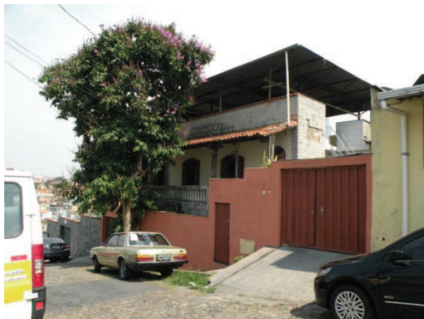
FOTO 30 - Vista da construção da Rua Adriano Modesto, nº 20, com tipologia e uso residencial, com 3 pavimentos.
