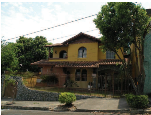
FOTO 83 – Vista da edificação da Rua Jacinto Vieira, nº 60, de uso residencial, com 2 pavimentos.
