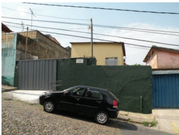
FOTO 26 - Vista da construção da Rua Adriano Modesto, nº 33, com tipologia e uso residencial, com um pavimento.
