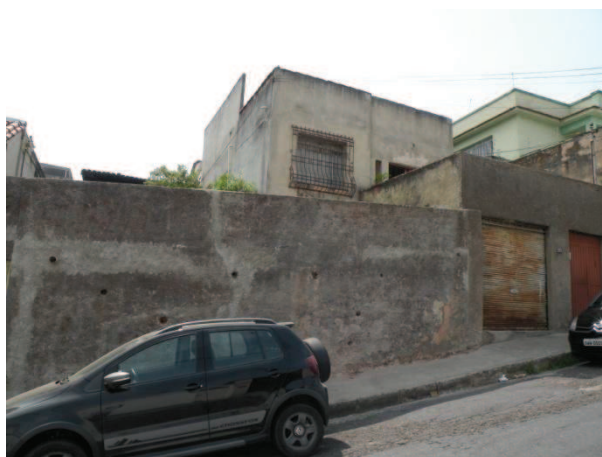
FOTO 36 - Vista da edificação da Rua Primeiro de Maio, nº 233, de uso residencial, com 2 pavimentos.
