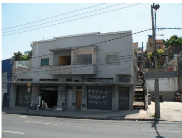
FOTO 95- Vista da edificação da Av. Antônio Carlos, nº 2116, de uso misto residencial e de comércio de calhas, com dois pavimentos.
