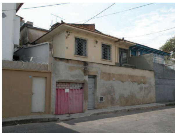
FOTO 38 - Vista da edificação da Rua Primeiro de Maio, nº 283, de tipologia e uso residencial, com 2 pavimentos.
