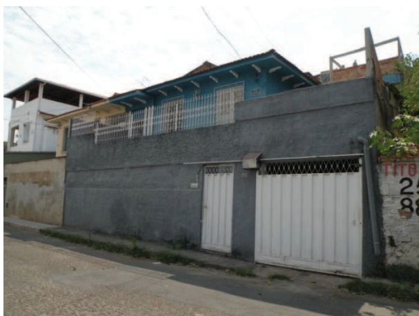
FOTO 39 - Vista da edificação da Rua Primeiro de Maio, nº 291, de tipologia e uso residencial, com 2 pavimentos.
