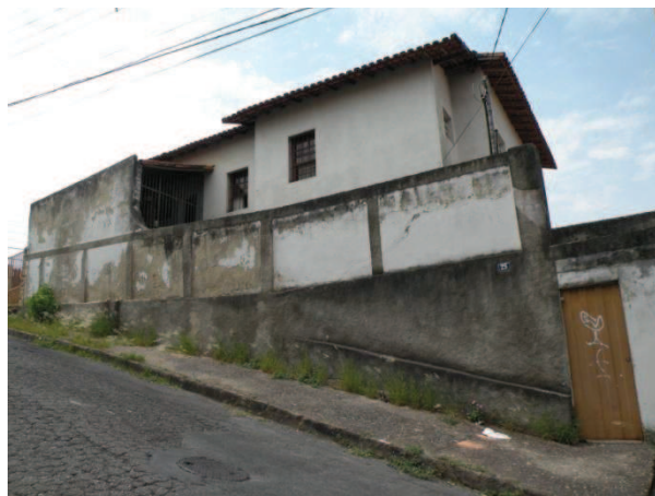
FOTO 62 - Vista da edificação da Rua Pedro Moura, 25, com tipologia e uso residencial, com 2 pavimentos.
