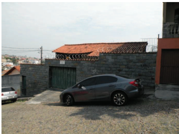
FOTO 31 - Vista da construção da Rua Adriano Modesto, nº 44, de uso residencial, com um pavimento.
