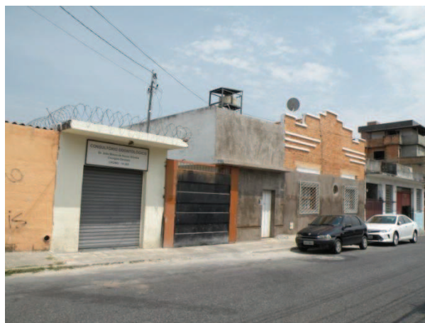
FOTO 74 - Vista da edificação da Rua Itapetinga, nº 577, com tipologia e uso misto de residência e serviço de odontologia, com 1 pavimento.
