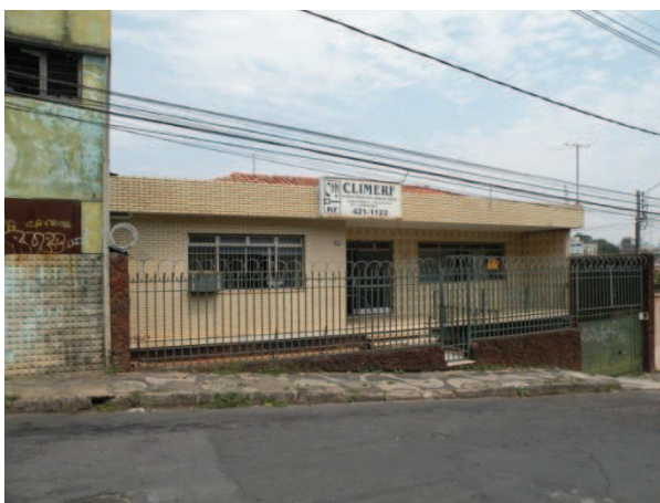
FOTO 51 - Vista da edificação da Rua Primeiro de Maio, nº 250, com tipologia residencial e uso de serviços de Clínica Médica, com 1 pavimento.
