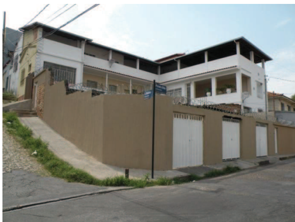
FOTO 24 - Vista da construção da Rua Adriano Modesto, esquina com Rua Primeiro de Maio, de uso residencial, com dois pavimentos.
