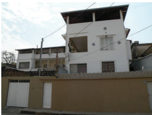
FOTO 37 - Vista da edificação da Rua Primeiro de Maio, nº 273, de tipologia e uso residencial, com 3 pavimentos.
