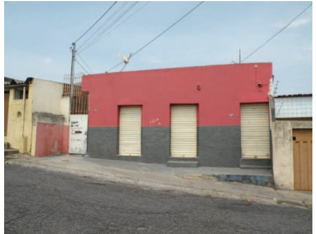
FOTO 66 - Vista da edificação da Rua Itapetinga, nº 701, com tipologia de galpão e uso não-residencial, com um pavimento.
