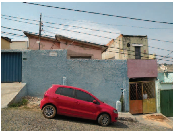
FOTO 25 - Vista do 2º lote à esquerda, situado à Rua Adriano Modesto, nº 51, de uso residencial, com dois pavimentos.
