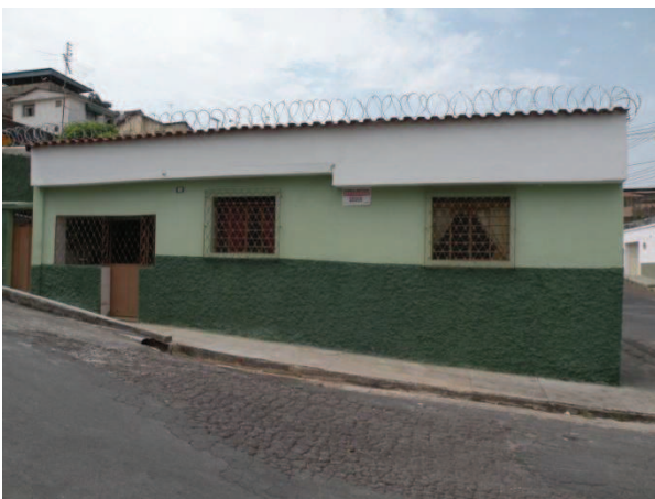
FOTO 57 - Vista da edificação da Rua Pedro Moura, esquina com Rua Primeiro de Maio, com tipologia e uso residencial, com 1 pavimento.
