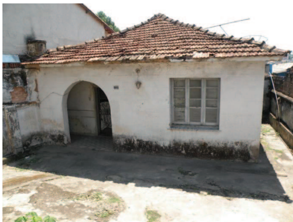
FOTO 75 - Vista da edificação da Rua Itapetinga, nº 722, com tipologia e uso residencial, com 1 pavimento.
