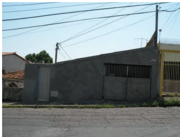
FOTO 76 - Vista da edificação da Rua Itapetinga, nº 712, de uso residencial, com 1 pavimento.
