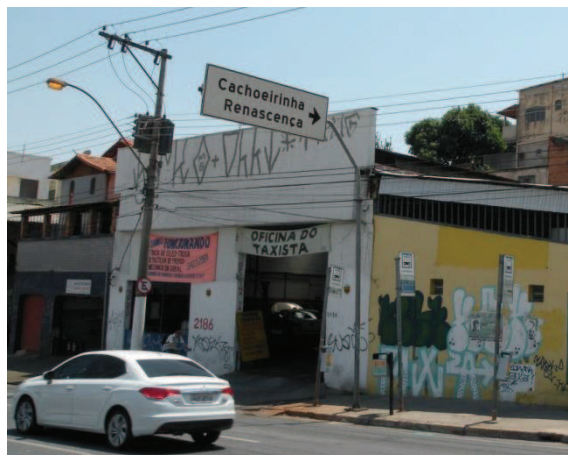
FOTO 98- Vista da edificação da Av. Antônio Carlos, nº 2186, com tipologia de galpão e uso de serviço de mecânica para táxis, com 1 pavimento.
