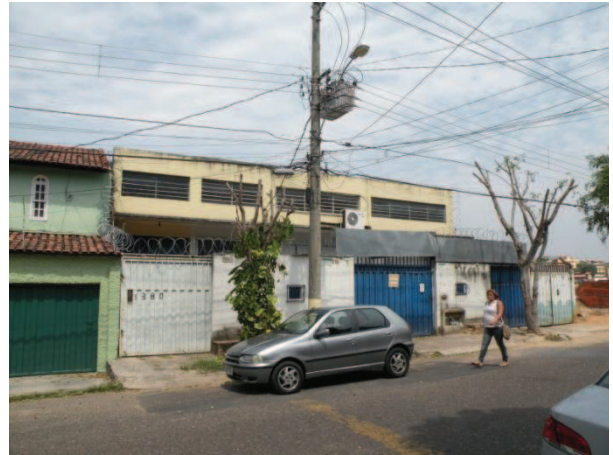
FOTO 42 - Vista da edificação na Rua Primeiro de Maio, nº 374, com tipologia e uso não-residencial de comércio, com 2 pavimentos.
