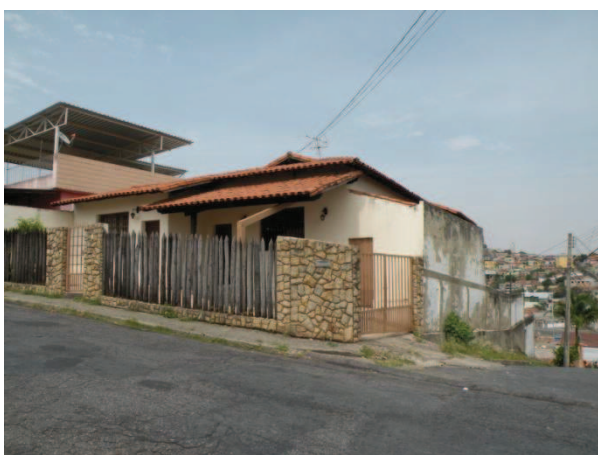
FOTO 63 - Vista da edificação da Rua Itapetinga, nº 735, esquina com Rua Pedro Moura, com tipologia e uso residencial, com 2 pavimentos.
