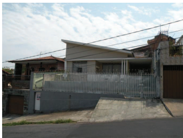
FOTO 86 - Vista da edificação da Rua Jacinto Vieira, nº 84, com tipologia e uso residencial, com 1 pavimento.
