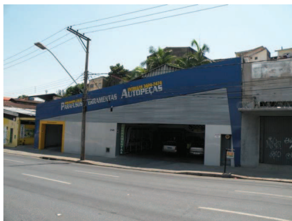
FOTO 96- Vista da edificação da Av. Antônio Carlos, nº 2146, com tipologia de galpão e uso de comércio de autopeças, com 1 pavimento.
