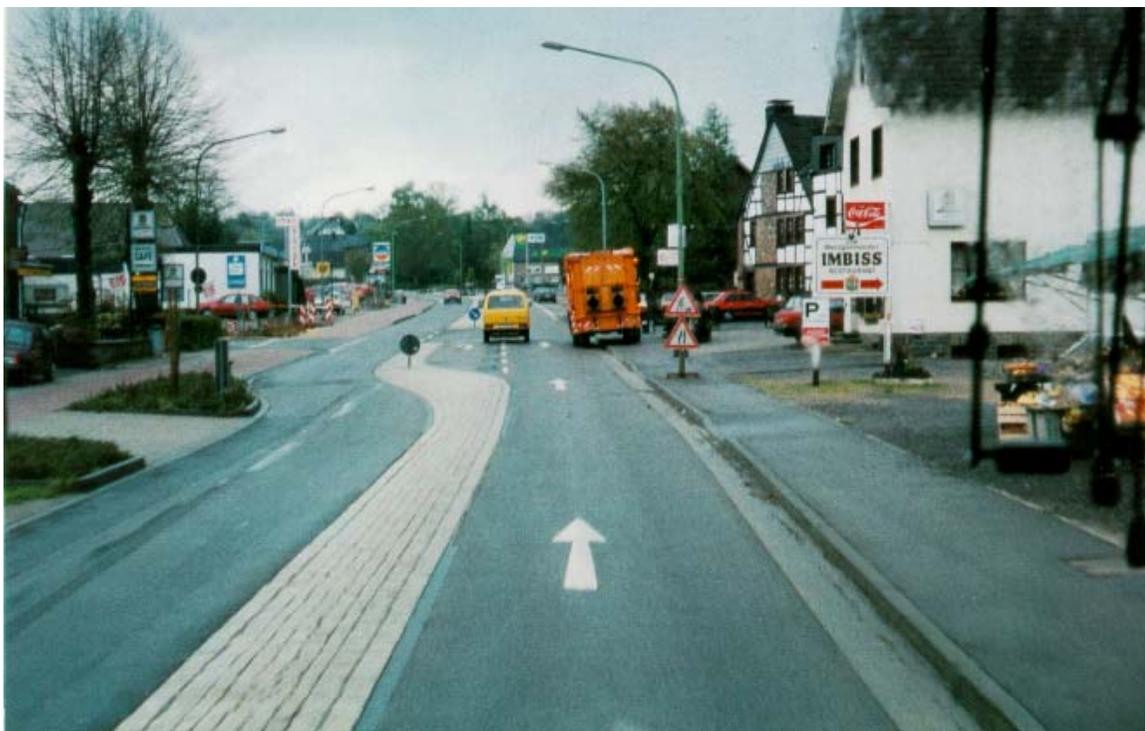
*Figura 3.28: Faixas de alinhamento construídas em blocos de concreto demarcando o canteiro central (Foto: Hass-Klau et Al).*
