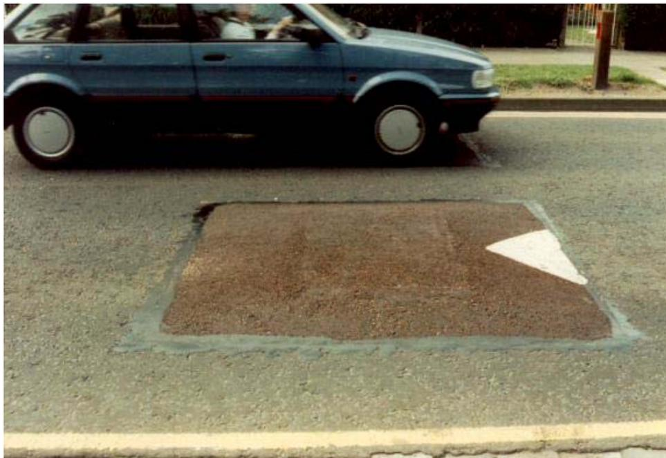
*Figura 5.3: Almofada em asfalto colorido (Foto: H. Barbosa )*
