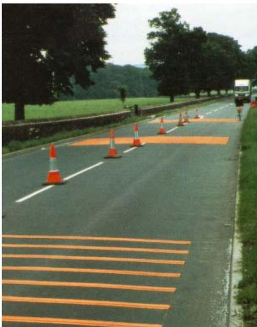
*Figura 3.6: Sonorizadores de diferentes dimensões, distribuídos ao longo da via destacados na cor alaranjada. (Foto: CSS et Al).*
