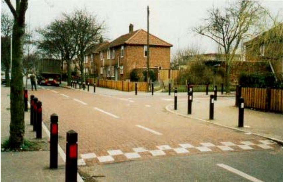
*Figura 3.5 : Platô - interseção elevada construída de blocos de concreto avermelhado, destacando a rampa de acesso e os balizadores que delimitam a calçada. (Foto: Hass-Klau et Al).*
