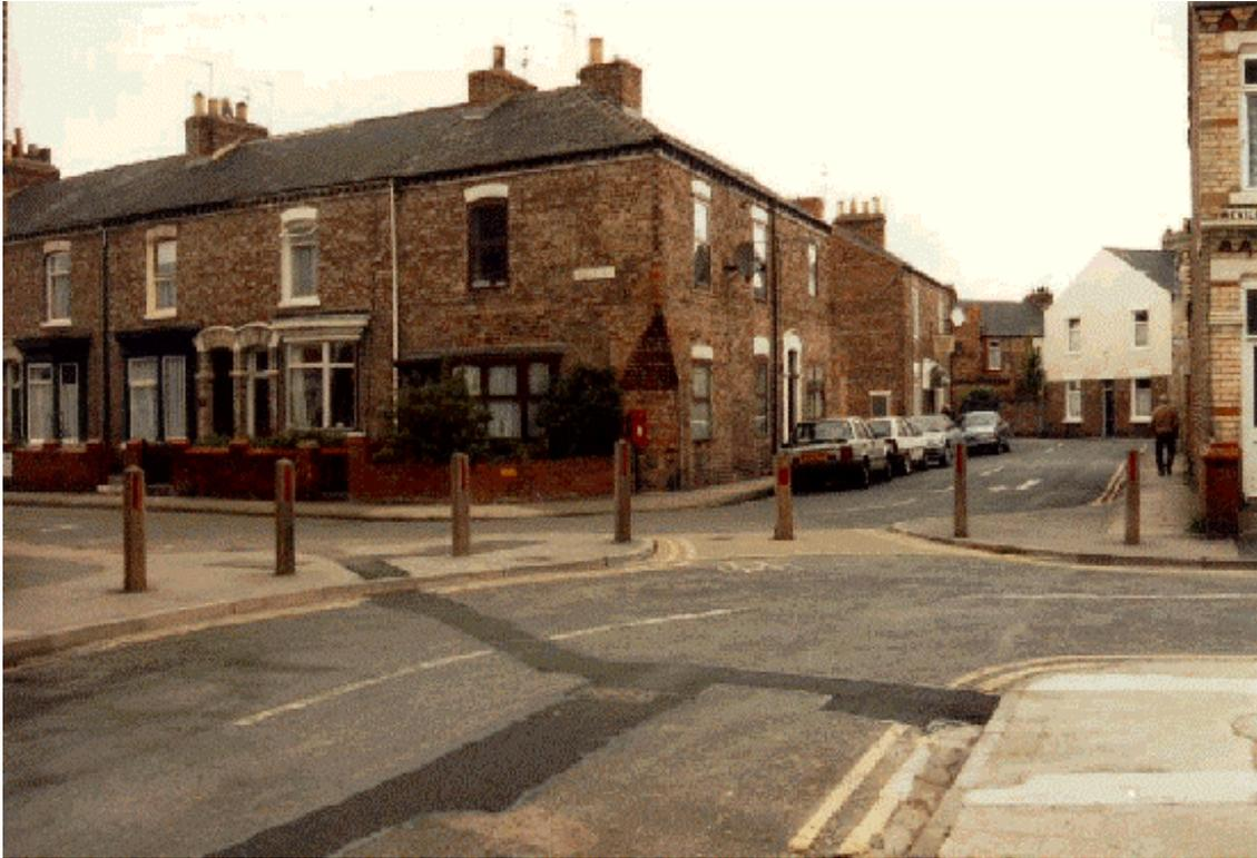
*Figura 3.17: Fechamento de interseção em cruz, eliminando a trajetória retilínea. Parte do fechamento tem o meio-fio rebaixado para facilitar o tráfego de veículos de duas rodas e possibilitar a passagem de veículos de emergência. (Foto: H. Barbosa).*
