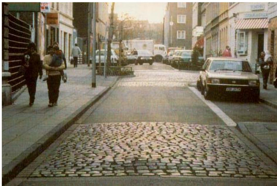
Figura 5.5: Ondulação construída com paralelepípedos, que pode ser utilizada como local de travessia de pedestres (Foto: Hass-Klau et Al)
