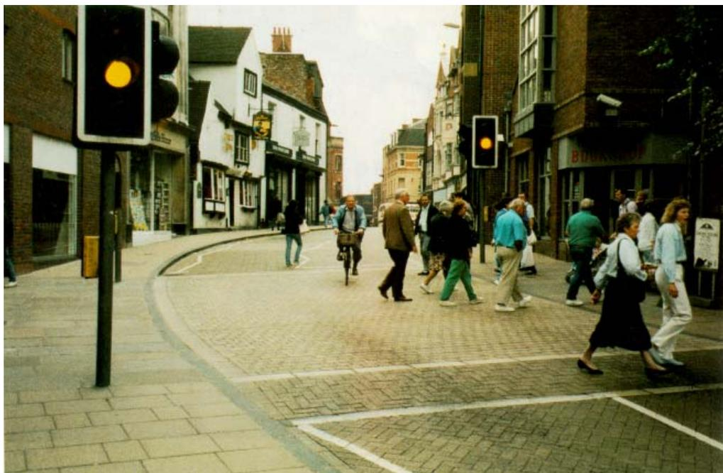
*Figura 3.3: Plataforma utilizada em travessia de pedestres semaforizada, destacando o uso de materiais diferenciados. (Foto: Hass-Klau et Al).*
