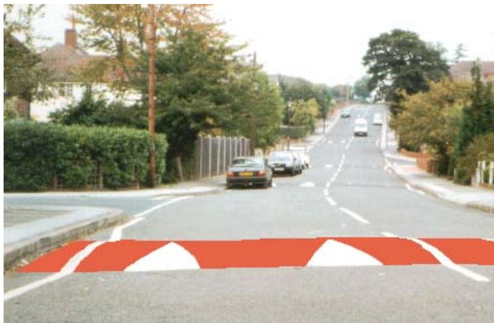
*Figura 5.1: Exemplos de ondulações em asfalto com pinturas indicando o sentido do fluxo de tráfego (Foto: CSS)*
