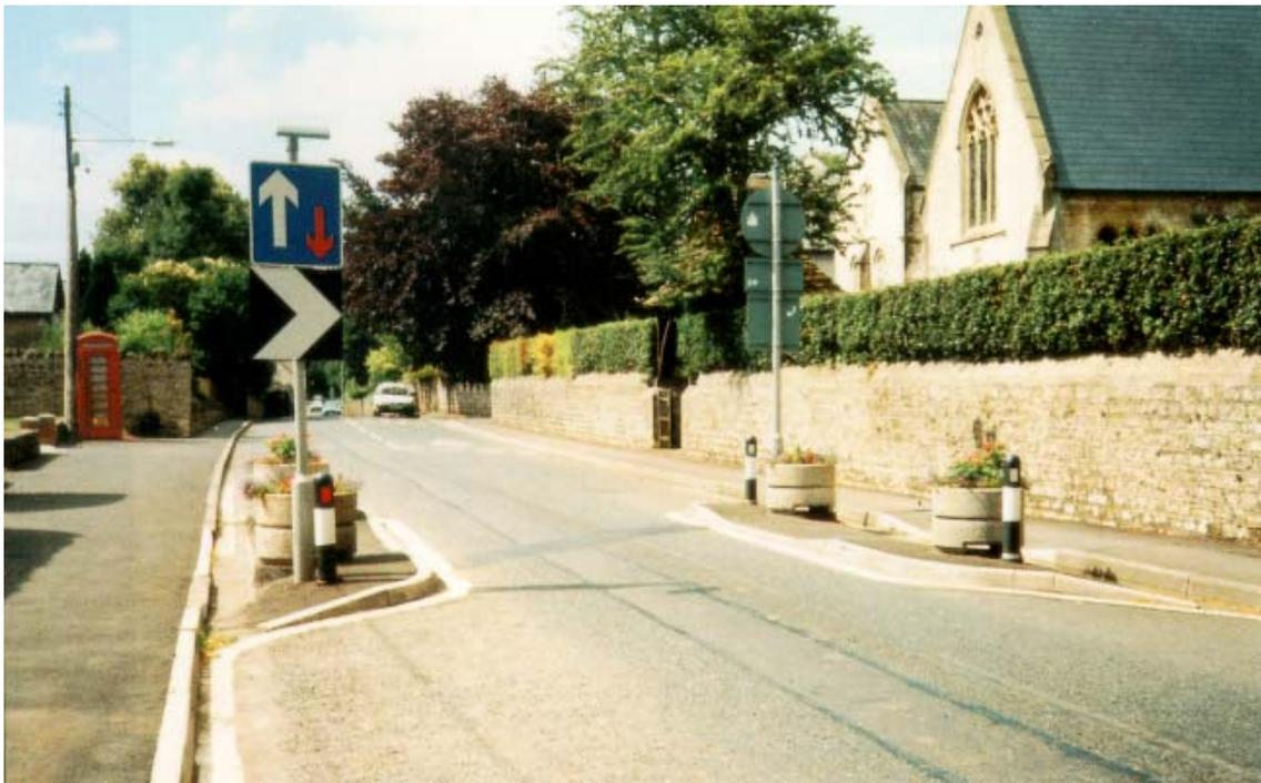
*Figura 3.9: Redução da largura da via permitindo apenas a passagem de um veículo*
