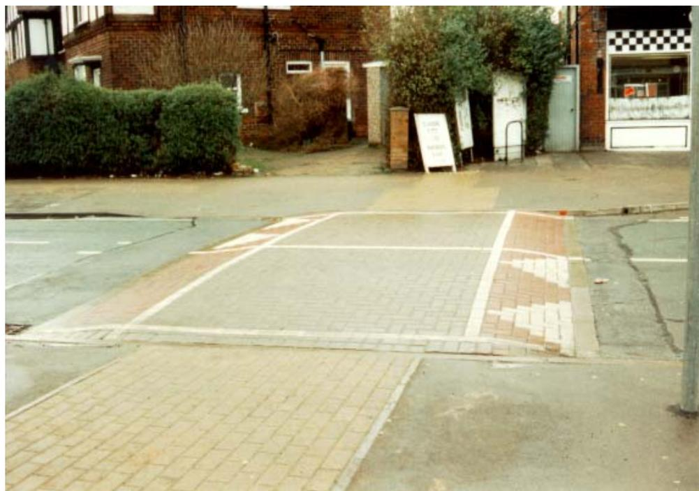
*Figura 5.2: Plataforma (perfil trapezoidal) revestida com blocos cerâmicos (Foto: H. Barbosa)*
