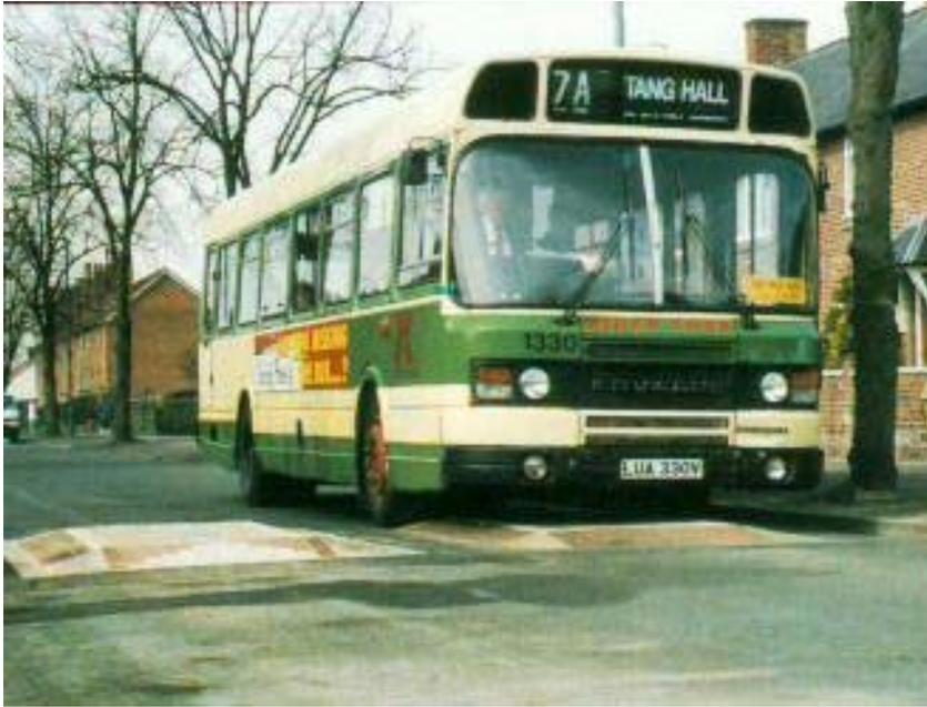
*Figura 3.4: Par de almofadas em via de mão dupla, construída em blocos coloridos; seta direcional de tráfego executada em blocos brancos. A foto ilustra a utilização de almofadas em rotas de coletivos. (Foto: DoT)*
