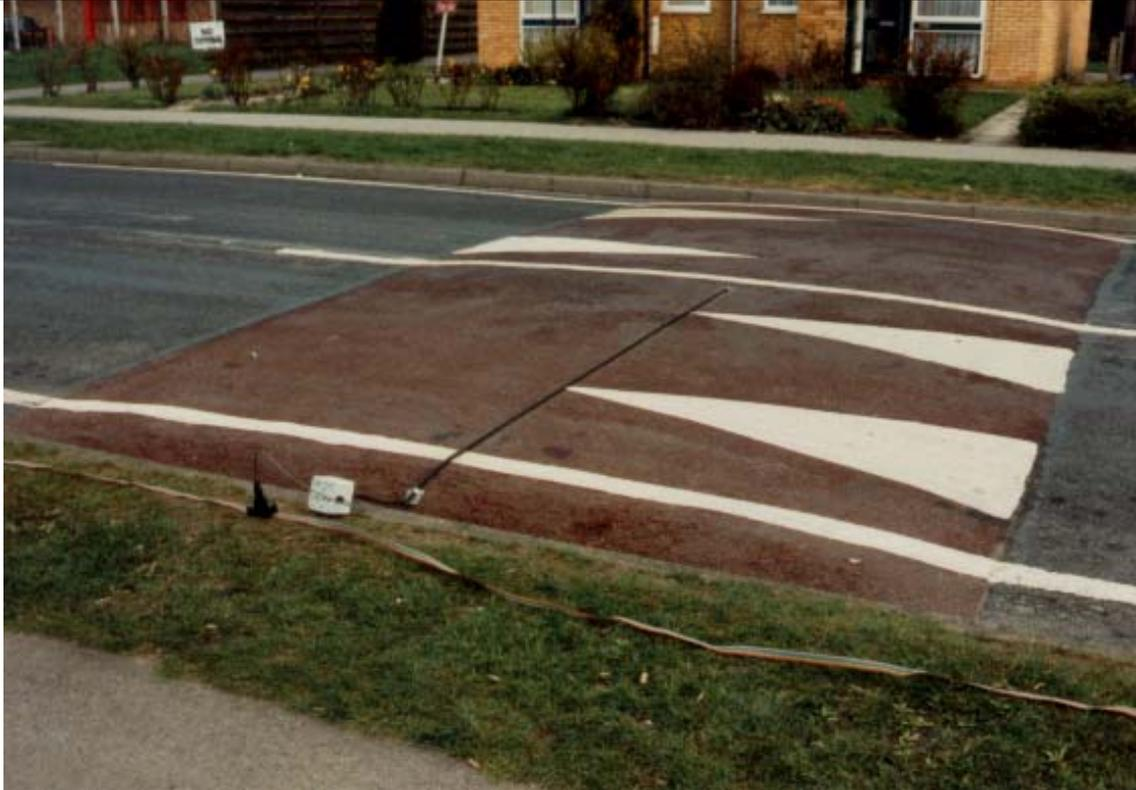
*Figura 3.2: Ondulação construída em material asfáltico na cor avermelhada, destacando o dispositivo em relação a pavimentação da via. (Foto: H. Barbosa).*
