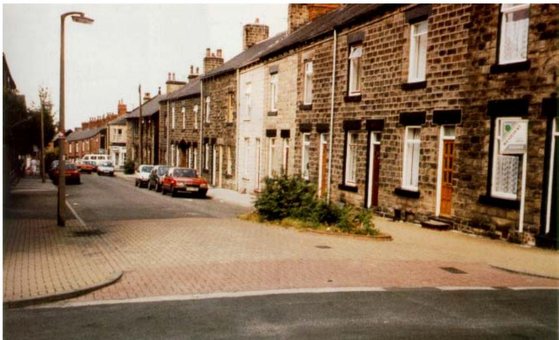
*Figura 3.15: Esquina com raio reduzido, em área residencial, propiciando uma maior redução de velocidade (Foto: Hass-Klau et Al).*
