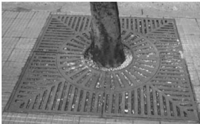
Figura 31 - Grelha metálica para cova de árvore
