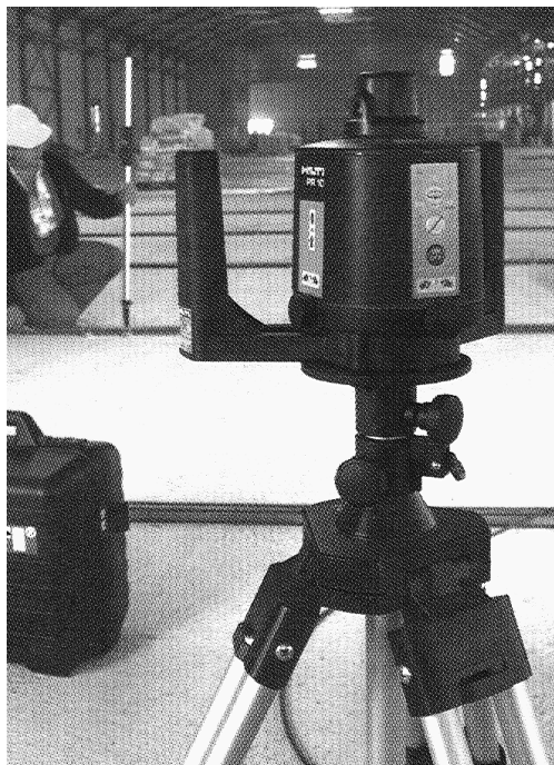
Figura 1 - Nivelamento a laser
